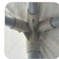
Unión estructural: Esquina
