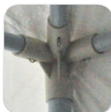
Unión estructural: Esquina
