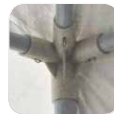
Unión estructural: Esquina
