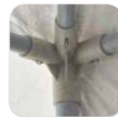
Unión estructural: Esquina
