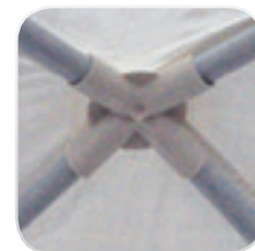
Articulación de barra metálica en cumbrera
