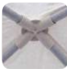
Articulación de barra metálica en cumbre
